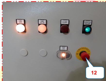
L'impianto è dotato di quadro elettrico (J) di alimentazione comando per la gestione completa di macchinari incorporati (fatta eccezione per la pulizia del filtro a maniche).
